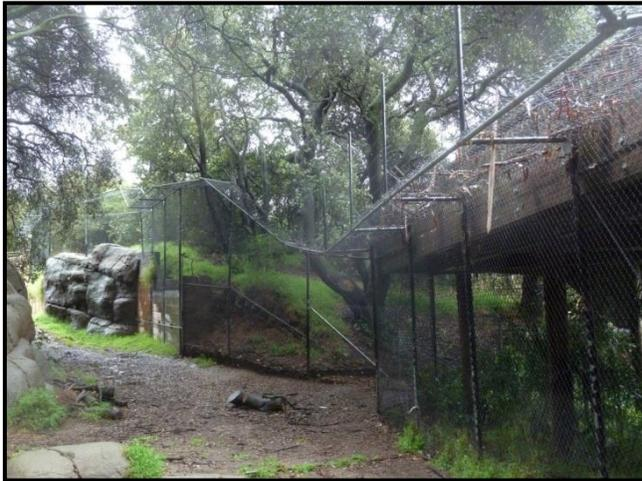
*Barrera de contención de malla con un ángulo superior de 90 grados*
